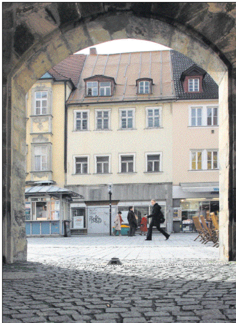
Denkmal in desolatem Zustand: Das Anwesen Maxstraße 19 (Bildmitte) darf dennoch nicht abgerissen werden. Es soll saniert werden. Foto: Lammel
